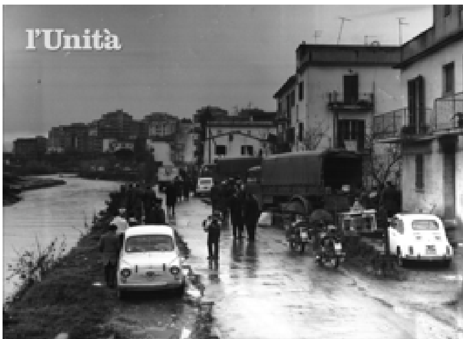
Figura 1 | Via Frassineto dopo l'alluvione del 1965, prima che venissero realizzati gli argini: sulla destra la cortina di edifici che fu poi espropriata e demolita per far posto alla nuova strada. Fonte: l'Unità.
